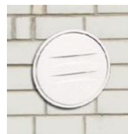
gemetseld in de wand
